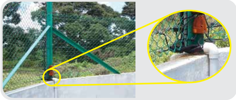
Gambar 3 : Kawasan yang dibekalkan lebih daripada satu energizer yang berlainan yang telah synchronized untuk dibekalkan kepada pagar elektrik.
