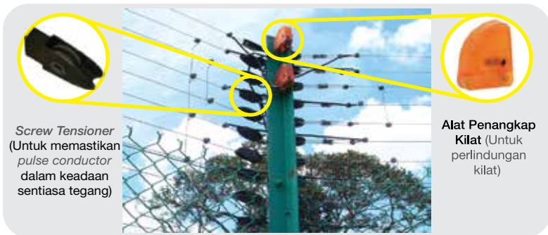
Gambar 4 : Sistem perlindungan kilat dan komponen yang digunakan.
