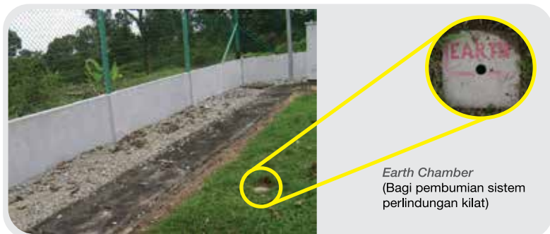
Gambar 5 : Sistem pembumian pemasangan pagar elektrik.
