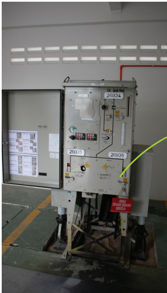
Gambar 11: Ring Main Unit (RMU) Gearsuis yang terlibat dalam Kemalangan
