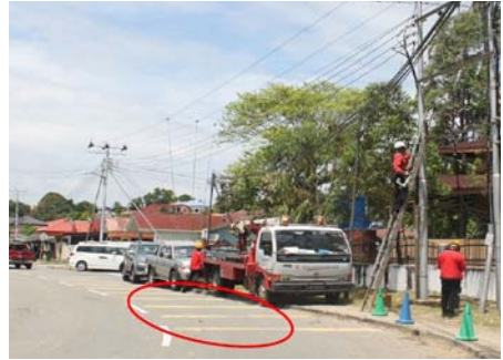
Gambar 4: Notis dan papan tanda 'awas' tidak diletakkan di kawasan tapak.
