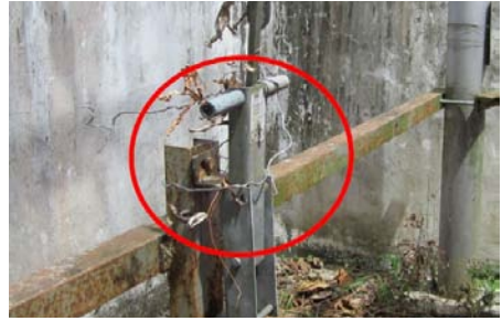
Gambar 8: Suis pengasing tidak dikunci dengan sempurna dan tanpa notis 'awas' dan hanya dikunci menggunakan dawai sahaja.
