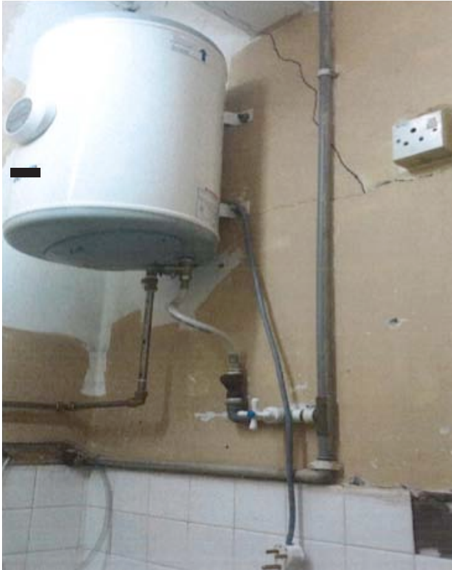
Gambar 19: Kemalangan elektrik maut melibatkan pemanas air jenis storan di rumah kediaman.
