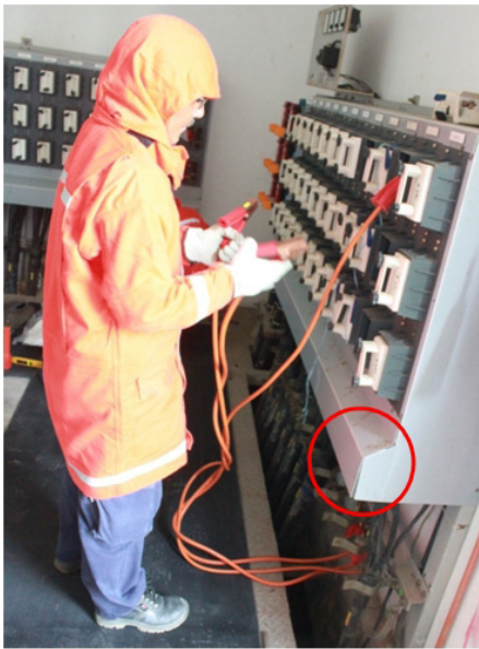
Gambar 1a: Ring Main Unit (RMU) di P/E GR5 menunjukkan keadaan suis gear bagi alatubah yang membekalkan bekalan ke pengguna dalam keadaan on walaupun bekalan masih belum diberikan.
