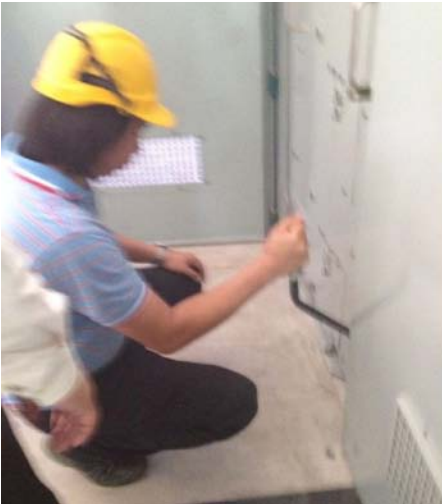
Gambar 13 : Tidak membuat pembuktian litar mati (PCD) dan mengeluarkan ( rack out ) pemutus litar (VCB) terlebih dahulu sebelum membuat pembumian pada litar tersebut.
