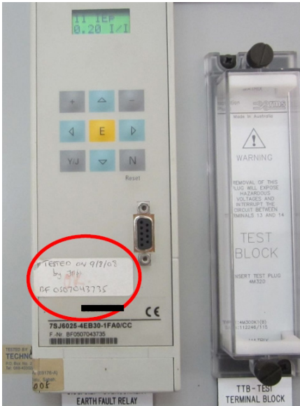
Gambar 9: Peranti perlindungan yang tidak ditentu ukur semula setelah tamat tempoh.
