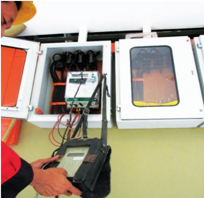
Alat Portable Working Standard (PWS) digunakan bagi memeriksa kejutuan meter elektrik.
