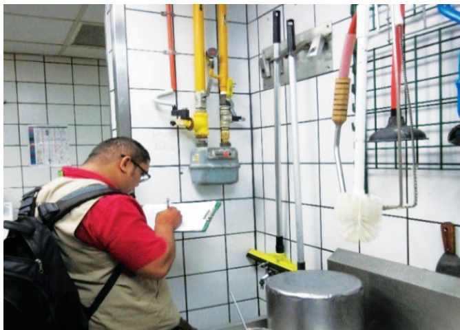
Pemeriksaan pemasangan gas untuk memastikan aspek senggaraan dan kendalian adalah selamat.
