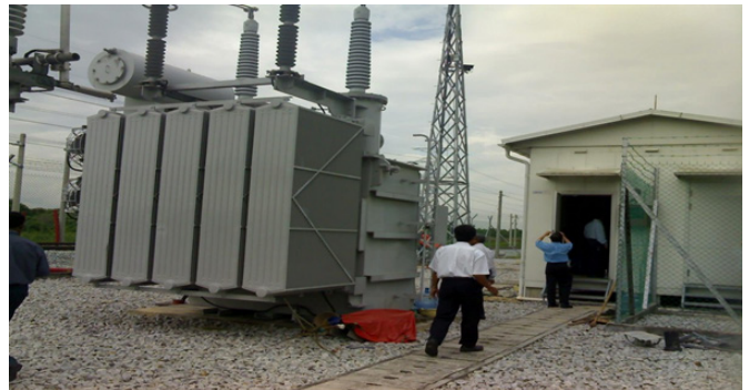
Pegawai ST sedang membuat pemeriksaan terhadap pemasangan TNB.
