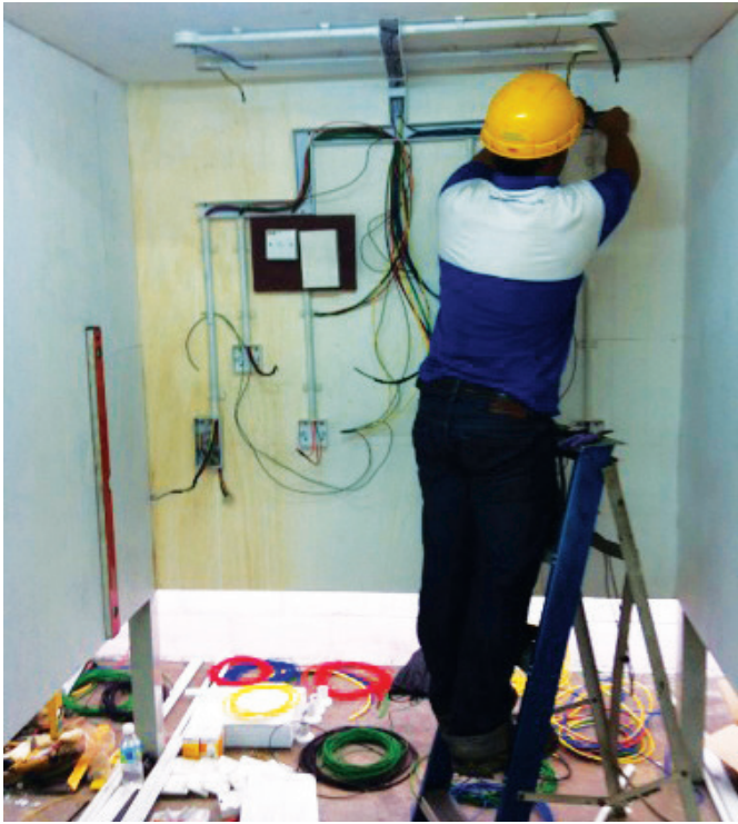
Ujian kerja-kerja pendawaian.
