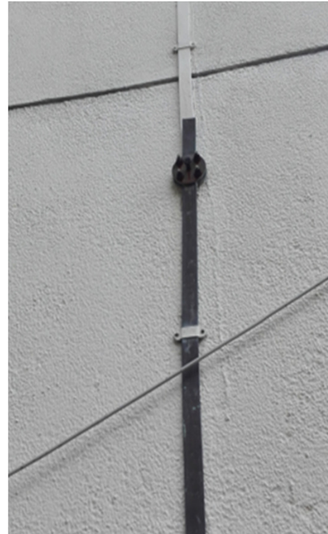
Building: Taman Perumahan Fera, Presint 8, Putrajaya.
